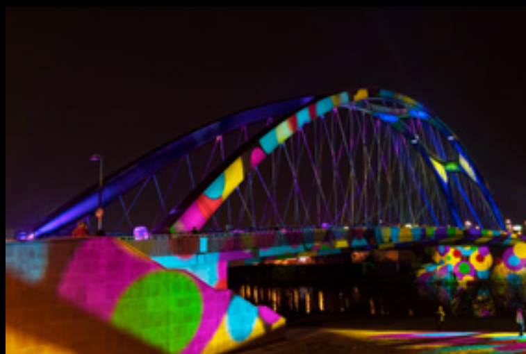
Abb. 6 Luminale Frankfurt 2014, Honsell-Brücke
